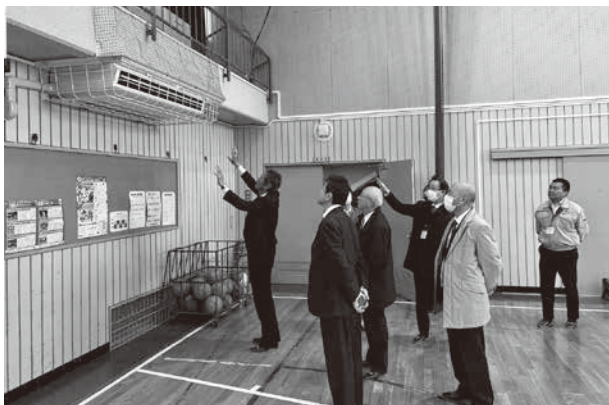
橘小学校 空調設備
