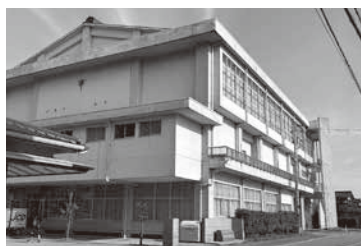
川北中学校 体育館
