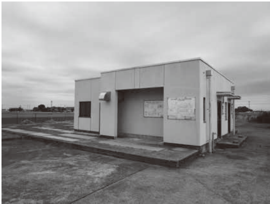
川北中部污水处理施設
