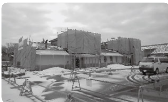
東部地区児童館工事現場（1月13日現在）
