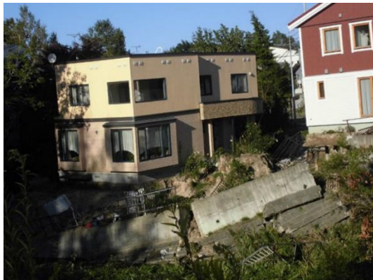
▼北海道胆振東部地震で倒壊した家屋
