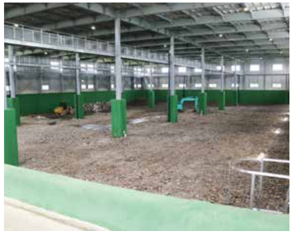
一般廃棄物最終処分場(平成30年5月竣工) 不燃ごみ選別後の残さを埋立する施設
