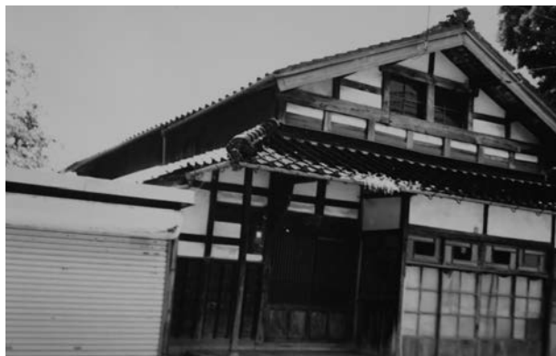
取り壊し前の空き家
