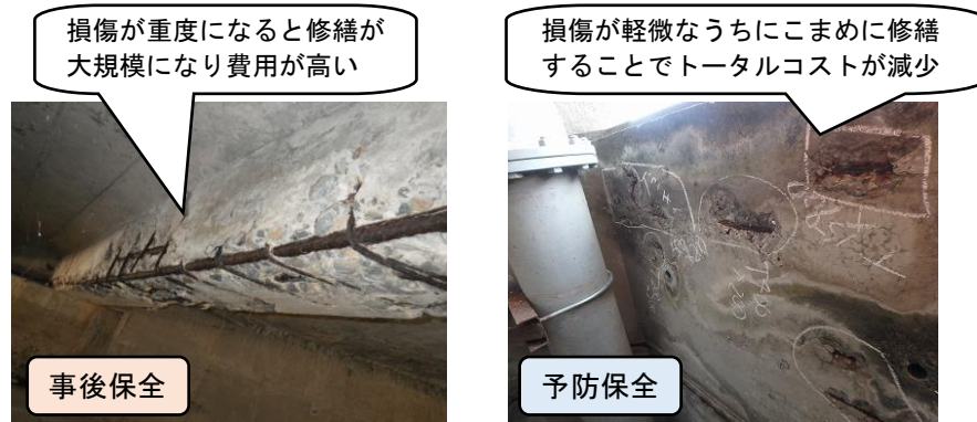
事後保全と予防保全のイメージ（コンクリートの鉄筋露出）
